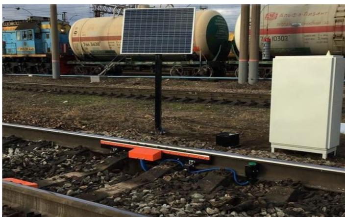
Рельсосмазыватели типа РСЛ, подающие смазку через питающие пластины, позволяют подать большое количество смазывающего материала, обеспечивая достаточную лубрикацию участков пути с высокой грузонапряженностью.
