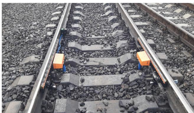
Подача смазки осуществляется через две питающие пластины с помощью двенадцати каналов на каждой пластине.
