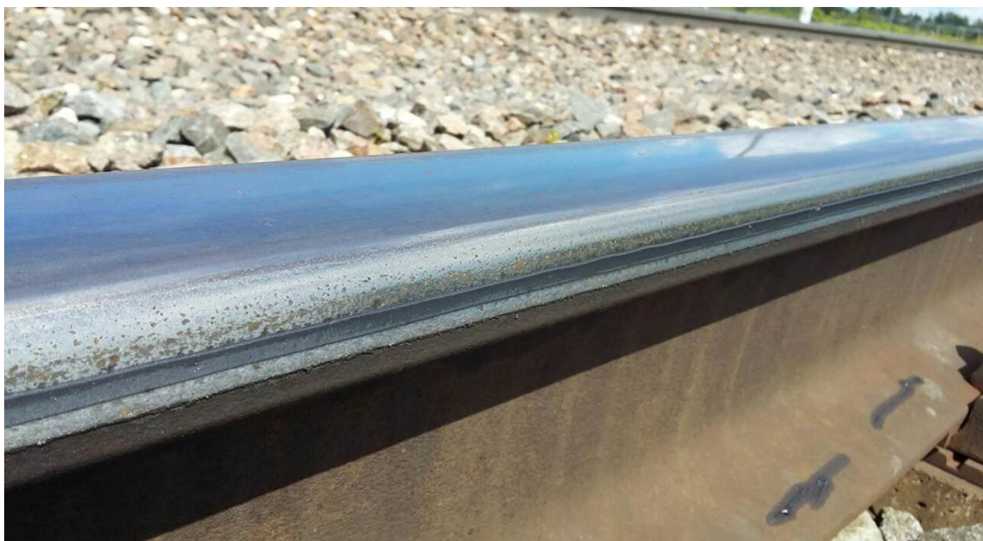
Нанесение смазки при установленном сопле диаметром 1.2 мм. на перегоне Туманово – Гагарин Московской железной дороги.
